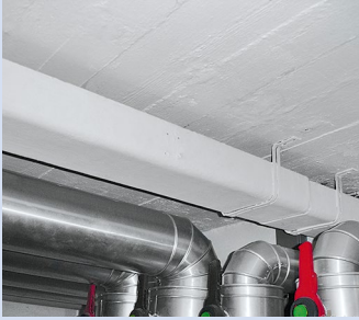
Kabelkanal aus Asbestzement
